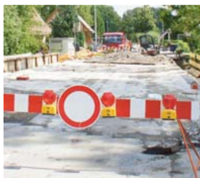
Bis September Baustelle: Die Rotachbrücke in Ittenhausen. BILD: WEX
